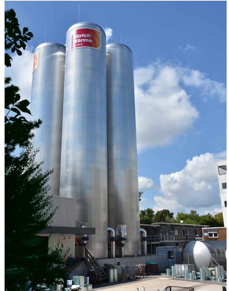
Die vier Behälter des Wärmespeichers sind über 27 m hoch.
