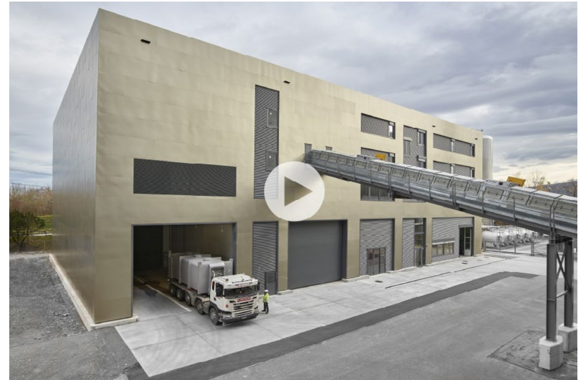
Der Bau der Logistikhalle Metallrückgewinnung im Zeitraffer (Film)
